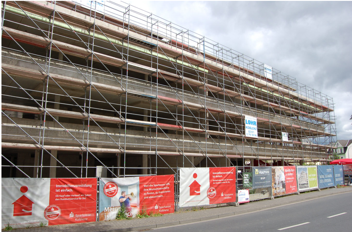
Bild 3: Ansicht Rohbau der künftigen Sparkassen-Geschäftsstelle Metternich
